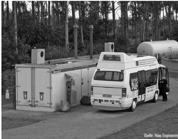
Abb. 19: Wasserstoff- tankstelle im Klärwerk Barth
