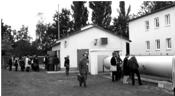
Die Elektrolysestation des Komplexlabors für erneuerbare Energien Foto: DWV
