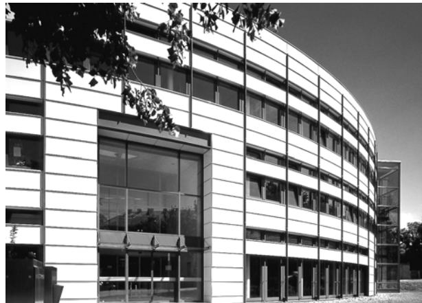
Viel Erfolg in den neuen Räumen! Hier ein Teil des neuen Gebäudes des Instituts für Solare Energiesysteme in Freiburg Foto: ISE/Kirsch
