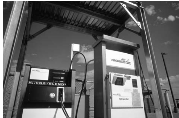
Rechts die Zapfsäule für komprimiertes Wasserstoffgas, links gibt es ein Gemisch aus Wasserstoff und Erdgas Fotos: Air Products
