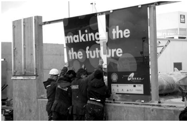
Baustelle Zukunft: Während der Errichtung von Islands erster Wasserstoff-Tankstelle
