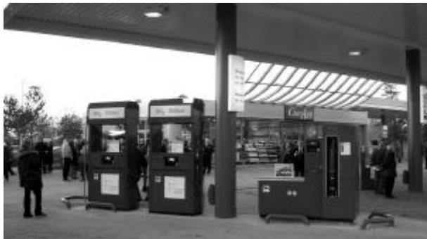
Die neue Tankstelle in Frankfurt-Höchst: links die beiden Gaszapsäulen für 350 und 700 bar, rechts gibt es tiefkalte Flüssigkeit Foto: DWV
