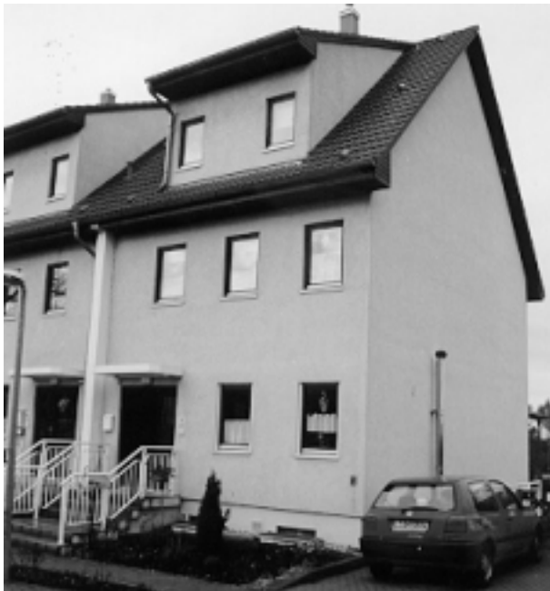
Erdgashaus in Machern bei Leipzig, demnächst mit Brennstoffzelle Foto: Verbundnetz Gas AG
