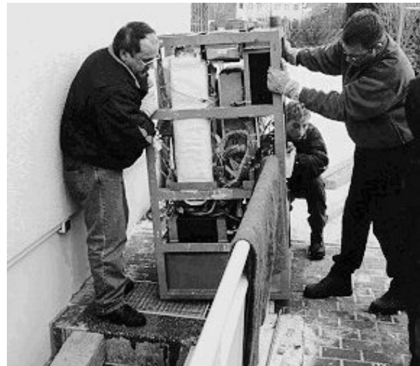
Gaaanz vorsichtig: die Brennstoffzelle für Machern wird in den Keller bugsiert.
