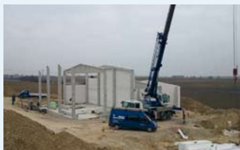
Auf der Baustelle bei Prenzlau: die Elektrolysehalle nimmt Formen an (Bild vom 17. Februar) Quelle: Enertrag
