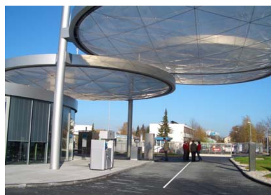
Linde-Wasserstoffzentrum in Unterschleißheim bei München
